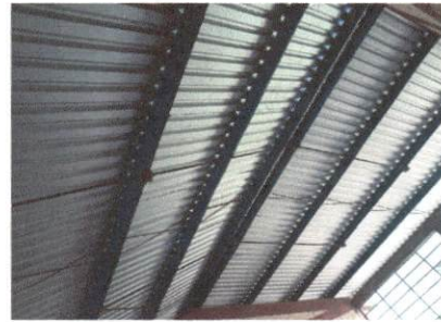
Foto 4: Mantenimineto de estructura de soprte de metal.
