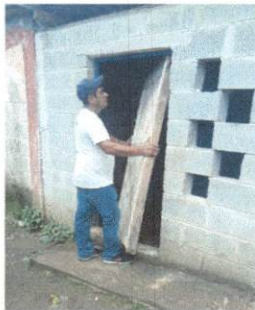
Foto 5: Sustrucción de puerta de madera por metal.
